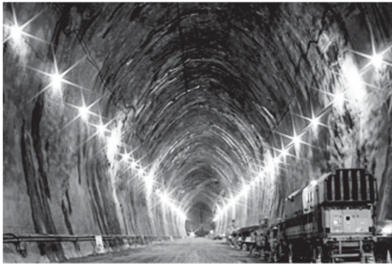
●地下備蓄サイトの地下空洞
