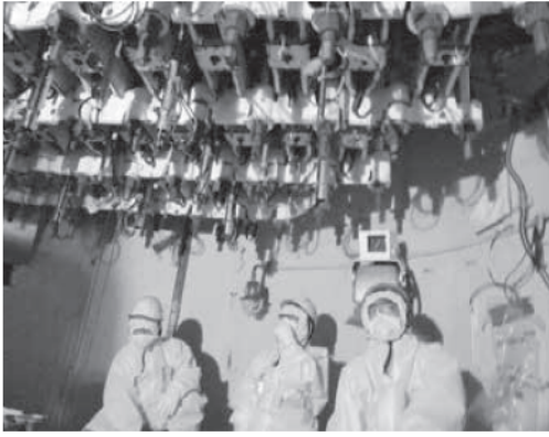
●5号機のペDESTAL内は狭く頭上には制御棒駆動装置の下部が並ぶ
