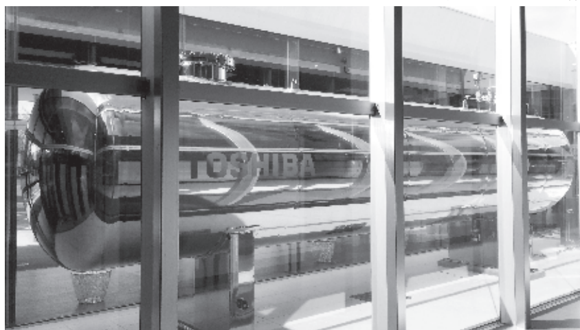
●水素貯蔵タンク
