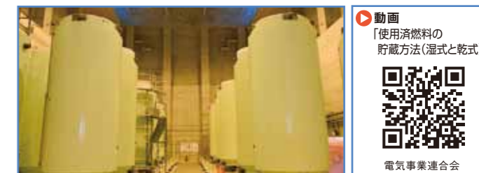
東海第二発電所使用済燃料乾式貯蔵施設(茨城県東海村) 写真提供:日本原子力発電(株)
