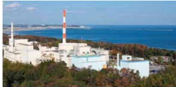
高速実験炉「常陽」
