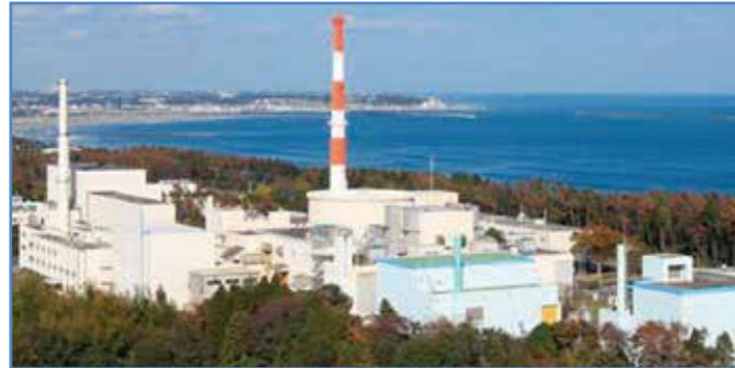
高速実験炉「常陽」
