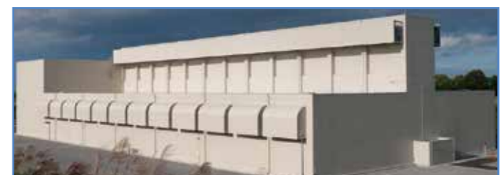
リサイクル燃料備蓄センター（青森県むつ市） 写真提供：リサイクル燃料貯蔵（株）
