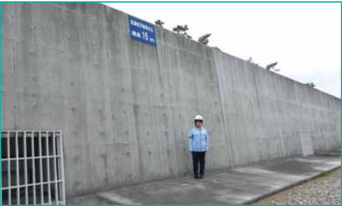
防潮堤の設置
