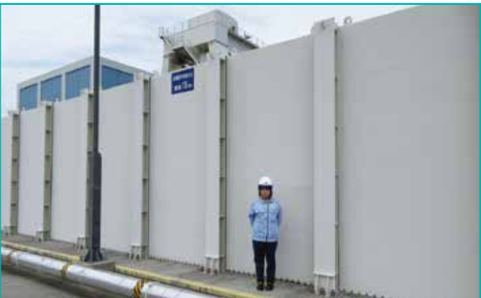
防潮壁の設置
