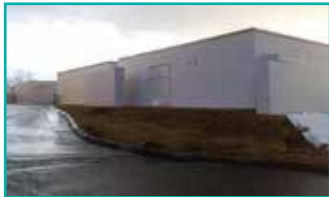
緊急時対策所（外観）
