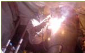
配管取り替えの様子
