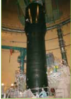
蒸気発生器取り替えの様子
