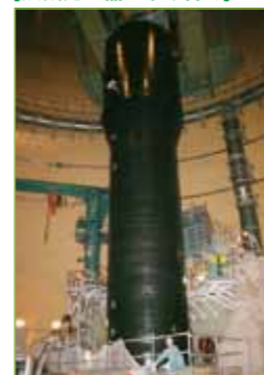
蒸気発生器取り替えの様子
