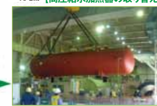
高圧給水加熱器取り替えの様子
