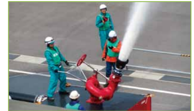
放水砲 写真提供:中国電力(株)
