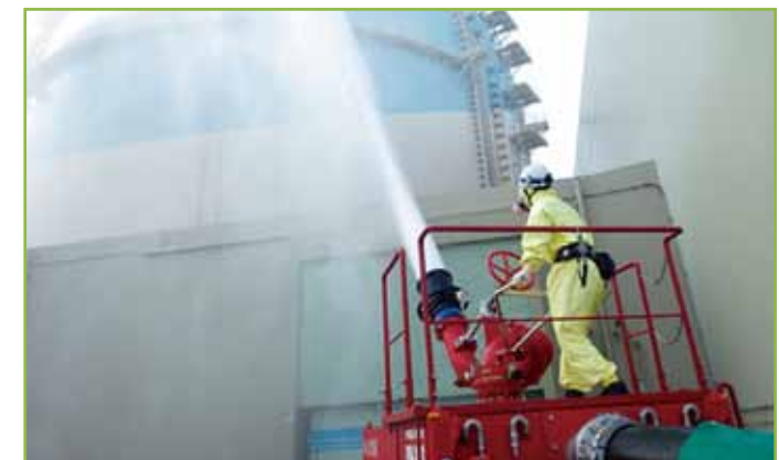
放水による放射性物質拡散抑制訓練
