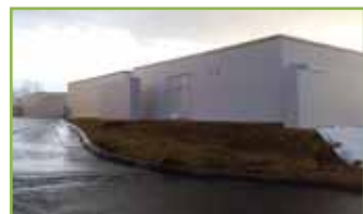
緊急時対策所(外観)
