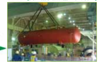
【高圧給水加熱器の取り替え】
