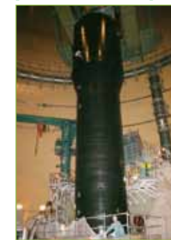
蒸気発生器取り替えの様子
