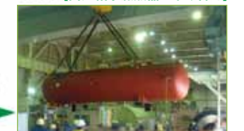
高圧給水加熱器取り替えの様子
